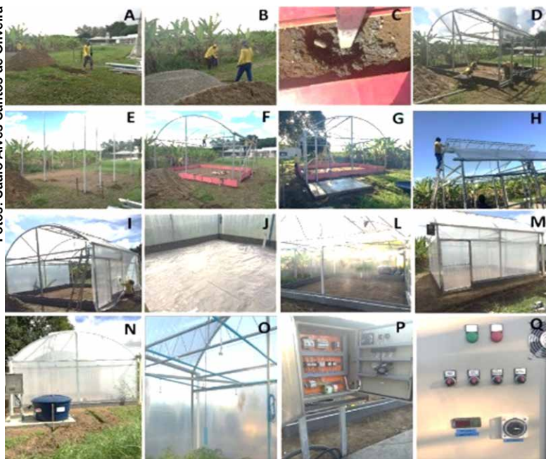
Figura 2. Montagem da câmara térmica de crescimento na Embrapa Mandioca e Fruticultura, para limpeza clonal e multiplicação rápida de mandioca.
